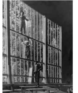
Die Glaser von Rossa bei der Arbeit auf der Baustelle des Pavillons für die Feier des hundertjährigen Jubiläums der Aufnahme Genfs in die Schweizer Eidgenossenschaft, 1914
